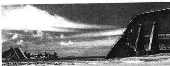
図-6 (a) 崩壊時の全景
